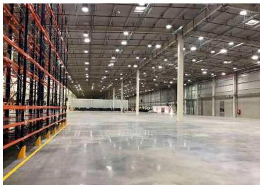
LA 14 | Centro de Distribución Yumbo, Valle del Cauca
